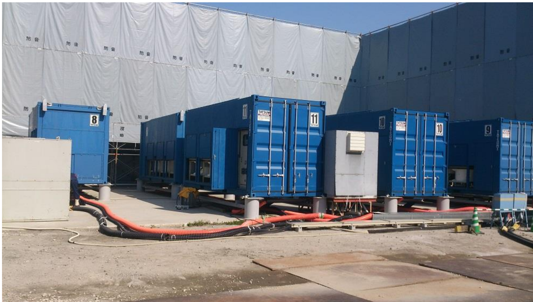
試験機：HH-3MC×7台
